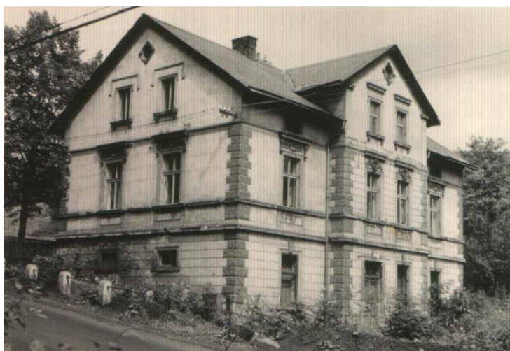
Tyssa Nr. 323 - Leopold Püschner ( 50.779758 , 14.035532 ) Metallwarenfabrik „Krautmühle“
